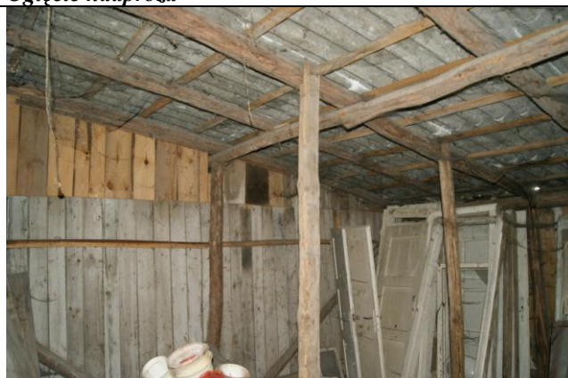
Nieszczelność pokrycia
