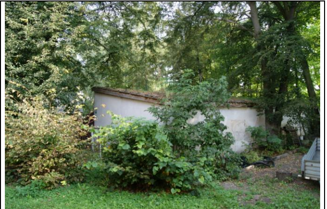
Widok od strony południowo-zachodniej
