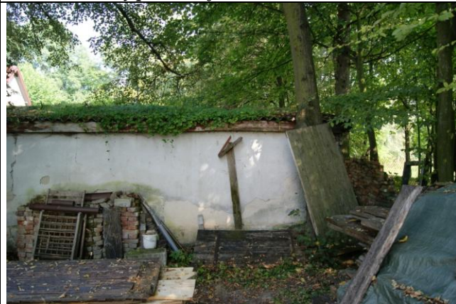
Widok od strony południowej
